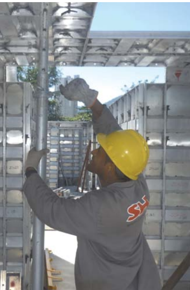
As fôrmas de alumínio da SH vêm com suporte para guarda-corpo
