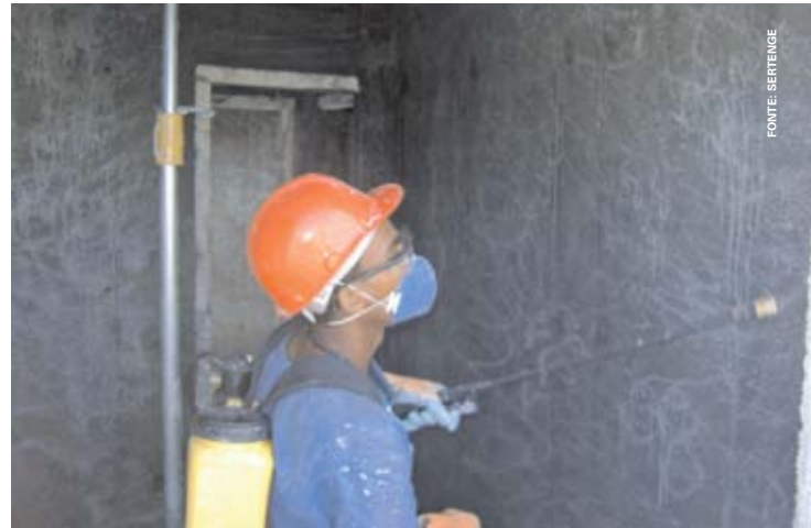
Operário realizando cura química
