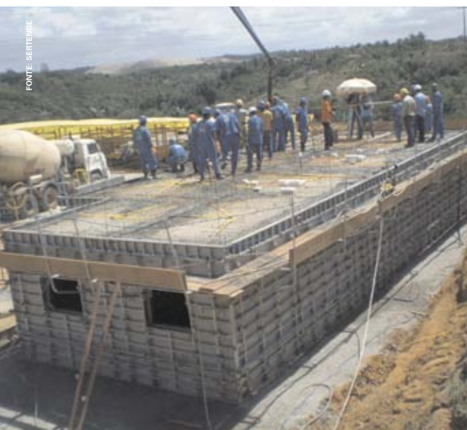
Concretagem geral do pavimento
