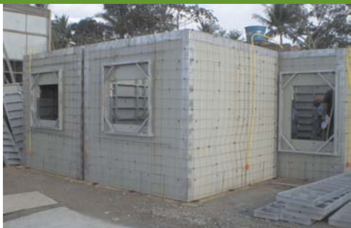
Fôrmas e instalações elétricas montadas
